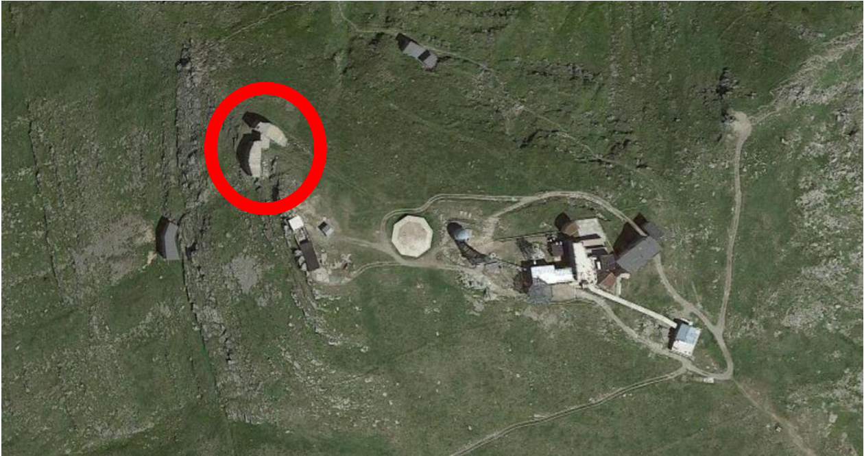
Fig. 1: foto aerea (Google Maps, il Nord in alto) con evidenziata in rosso nel settore a Ovest sulla parte sommitale del Monte Cimone (MO) la infrastruttura porta antenne Venda-Settepani.
